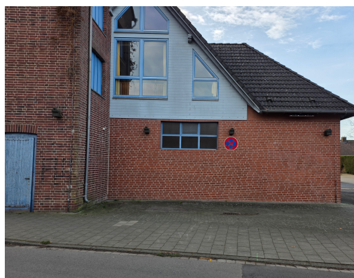
Abb. 3: Leerstehendes Feuerwehrgerätehaus Neuer Containerplatz vor Schlauchturm
